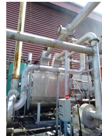
เครื่องแลกเปลี่ยนความร้อน (Heat exchanger) และติดตั้งหัวเผาเพิ่ม
