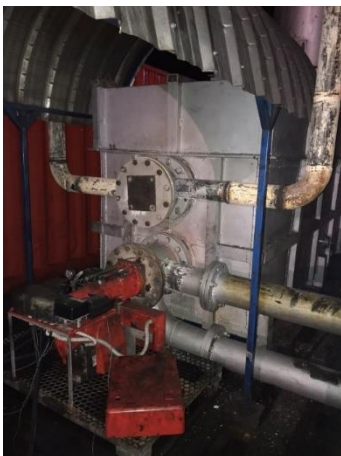
เตาเผาคว้น (Secondary burner)
