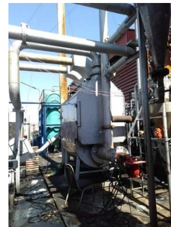
เครื่องแลกเปลี่ยนความร้อน (Heat exchanger) และติดตั้งหัวเผาเพิ่ม
